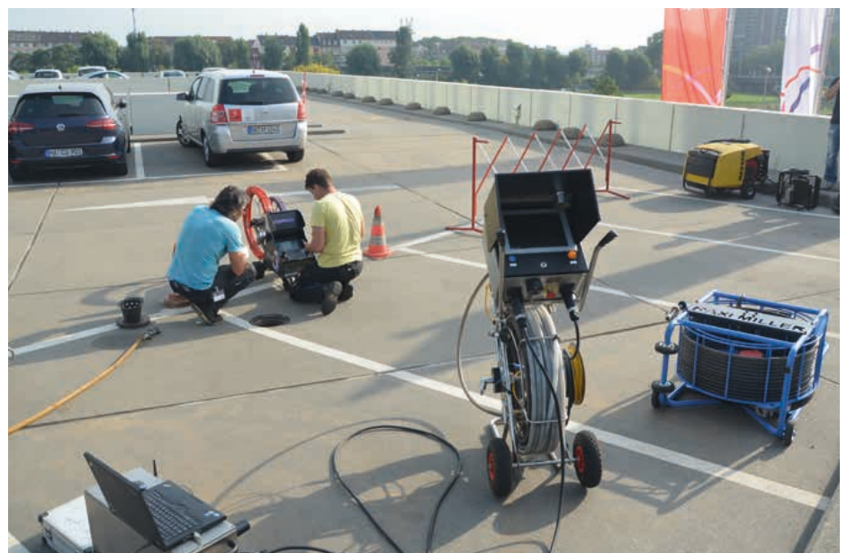
Baustellensituation auf einem Parkdeck in Mannheim: Der Betreiber möchte die Innenkorrosion der gusseisernen Entwässerungsleitungen stoppen, bevor Undichtigkeiten entstehen. Hier wurden von Wachtel mit dem lichthärtenden Liner bis zu 28 m lange Falleleitungen mit 90-Grad-Bögen in die Horizontale passgenau mit offenem Ende renoviert.
