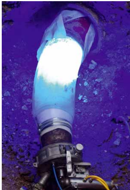
Die LED-Technologie für die Sanierung von Hausanschlussleitungen wird künftig über die neue Tochterfirma Bluelight GmbH an Kanalsanierungsunternehmen vertrieben.
